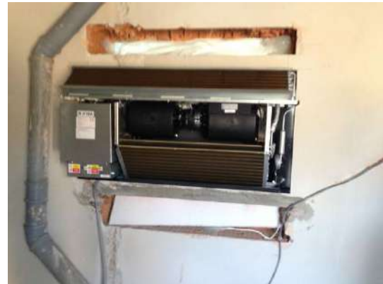
4. Namontovanie odvlhčovača a zapojenie elektrického kábla a odvodu kondenzátu
