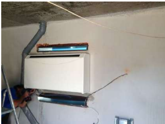
5. Namontovanie krytu odvlhčovača
