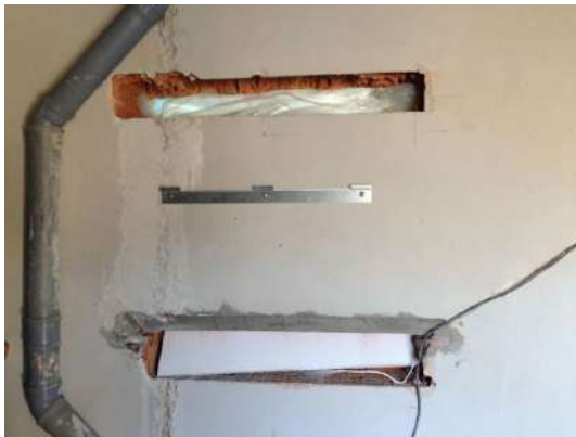
3. Namontovanie konzoly na stenu
