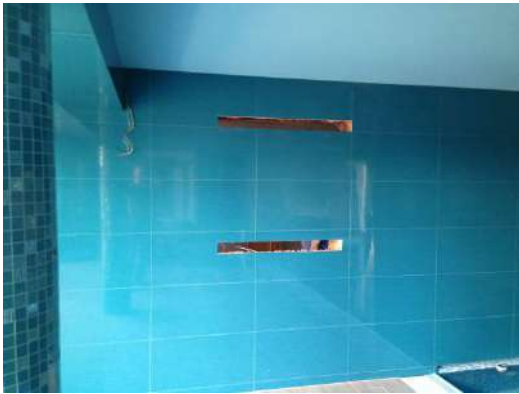
1. Vysekanie prestupov v stene
